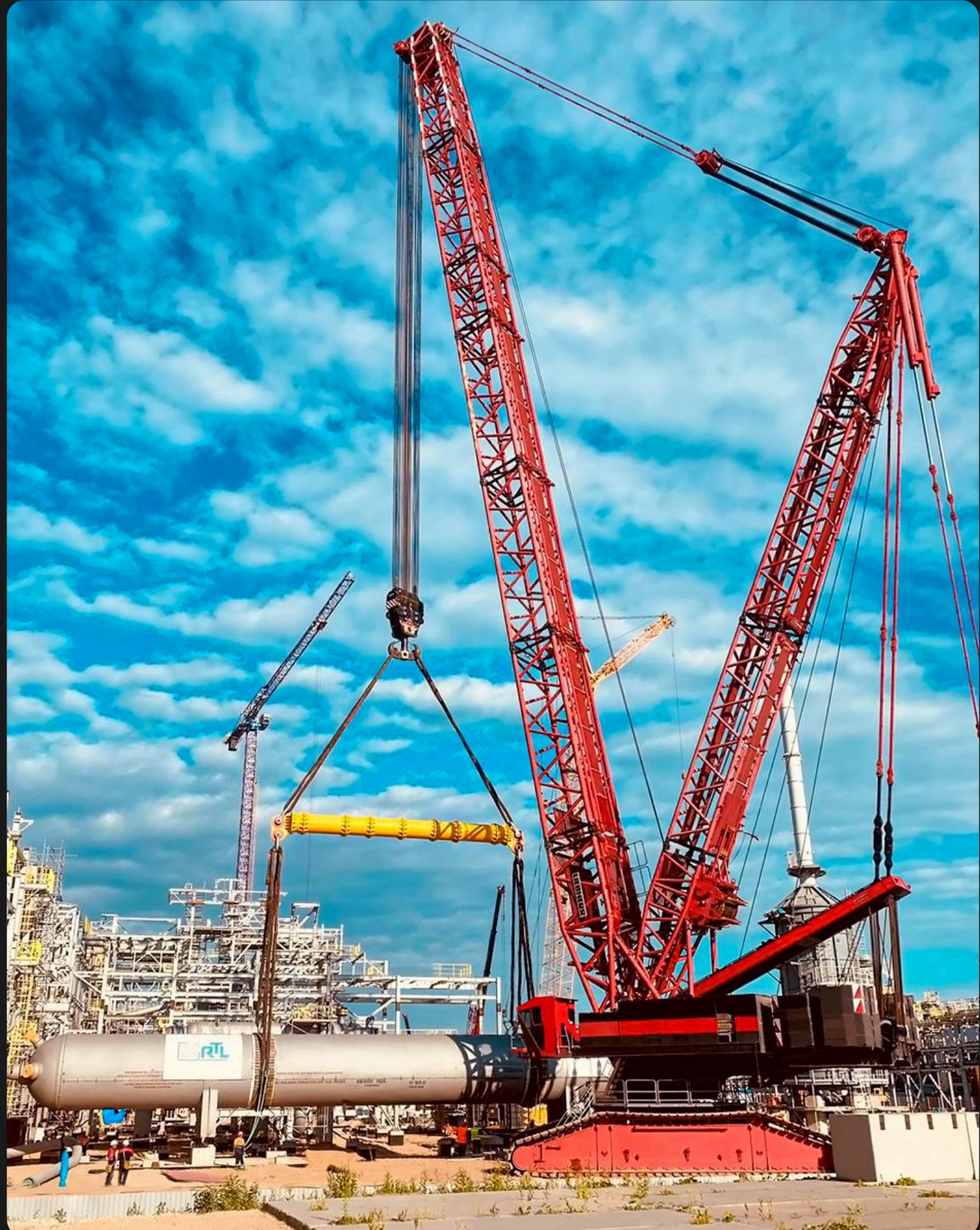
Liebherr LR 11350/ 1350 тонн
