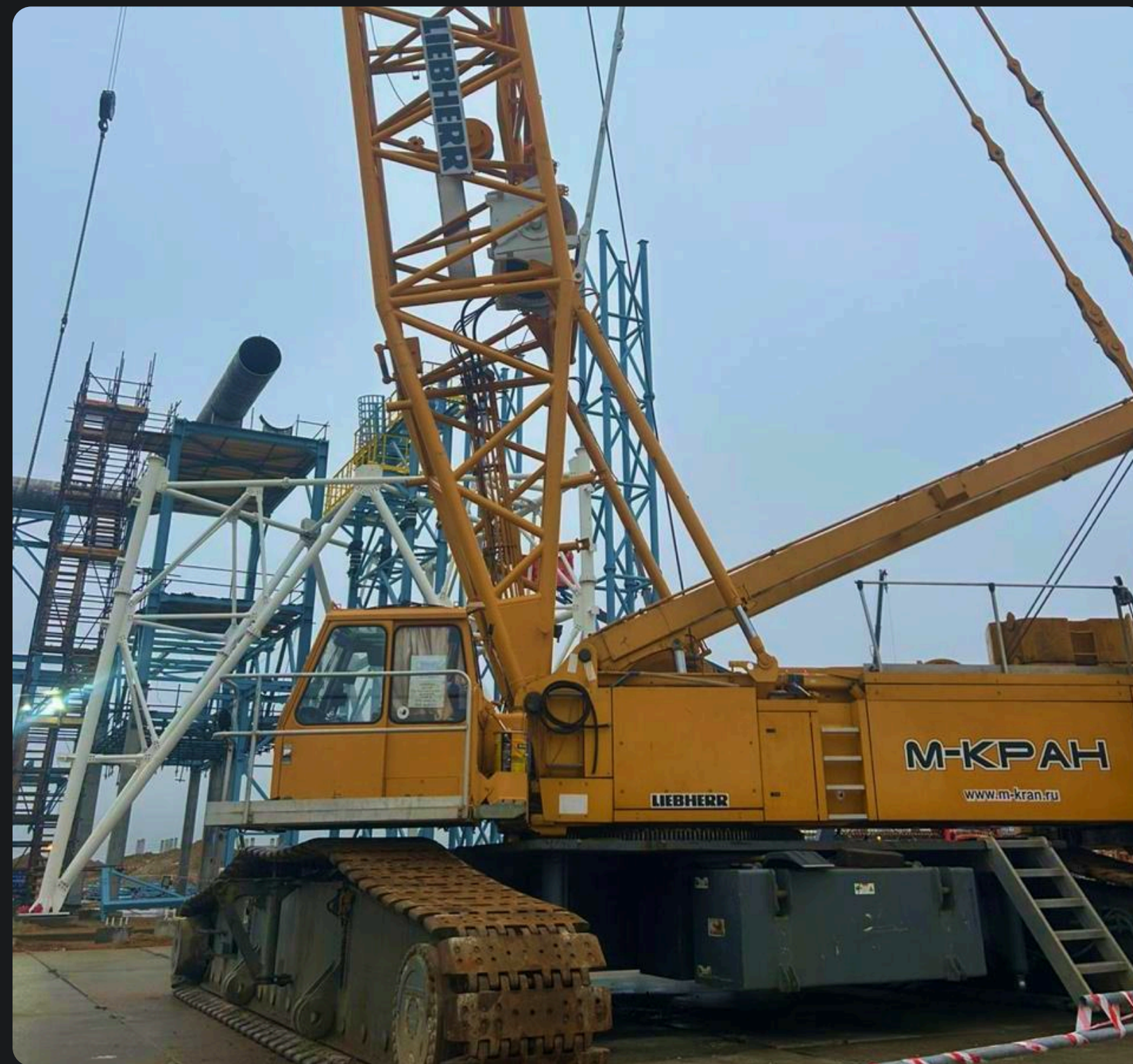
Монтаж опорных башен факелов на Балтийском химическом комплексе
