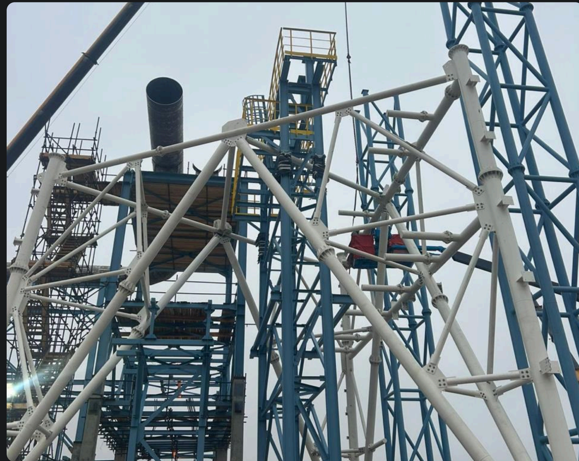
Работы по сварке и монтажу трубопроводов
